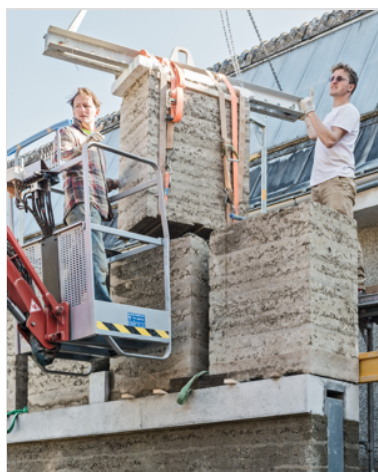
Recherche fondamentale du prototype: la maquette de la nouvelle construction avant sa finition.
