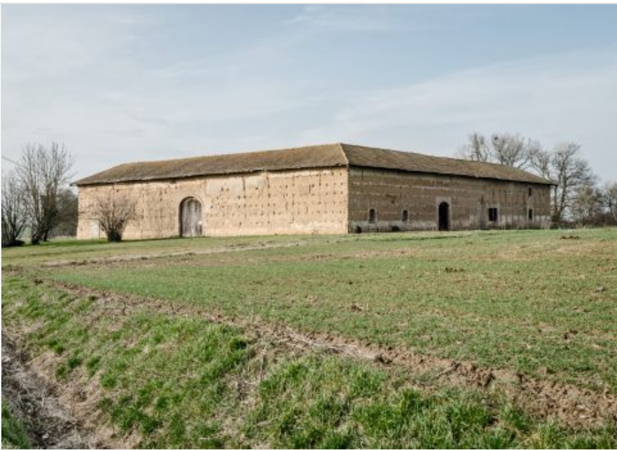
Exemple d'un bâtiment en pisé.
